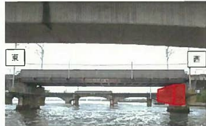
【施工場所写真】
